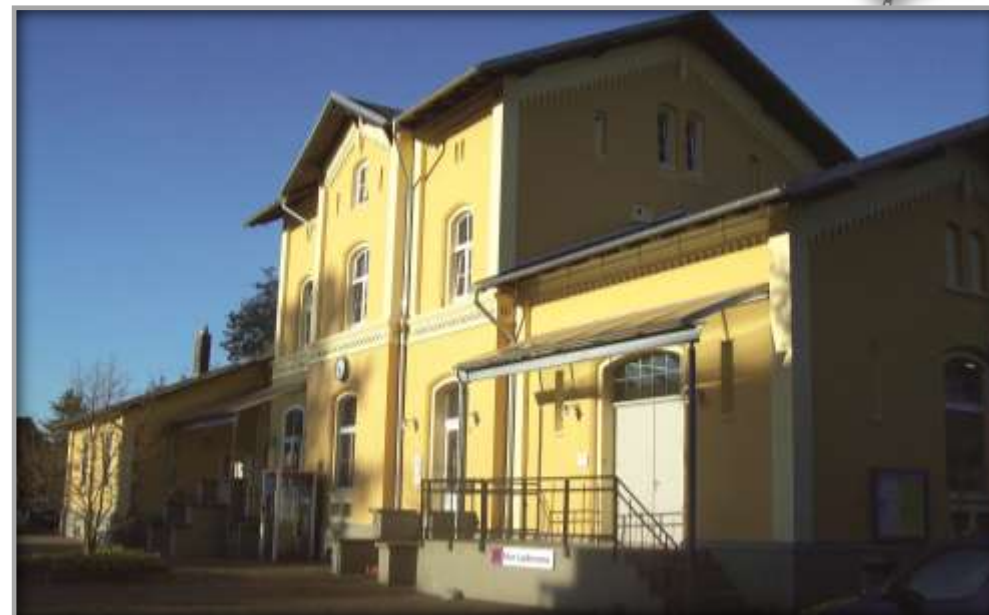
Außenansicht nach der Veräußerung und Entwicklung
