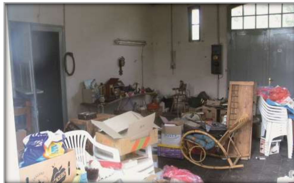
Innenbereich vor der Sanierung
